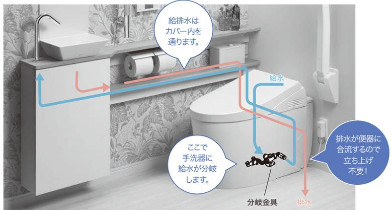
既存の給排水管をそのまま利用でき、床壁取り壊し工事も不要なので、リモデルにも最適です。
